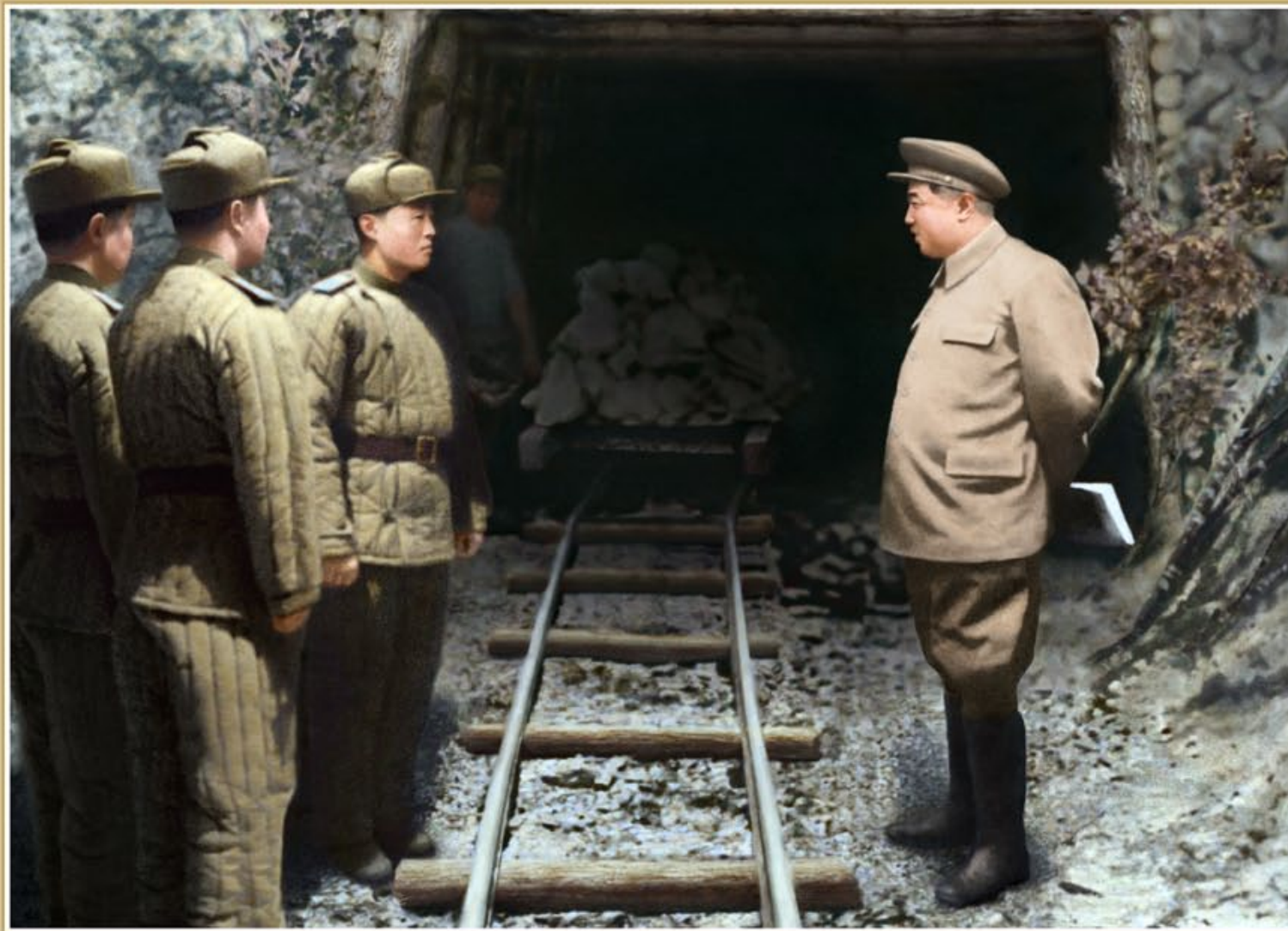
На стройке для сооружения туннельной позиции. Октябрь 40 года чучхе (1951).
